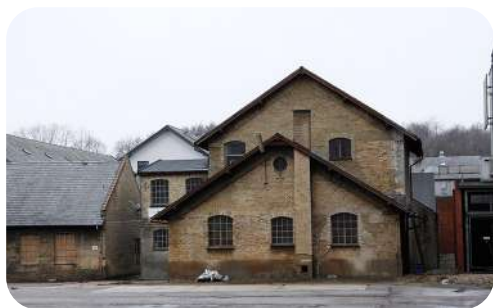
De ældste bygninger fra før 1900 er opført i gule sten med stejlt skifertag, støbejernsvinduer og 1-2 etager.
